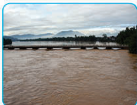
Hình 2.5. Lũ lụt nước dâng cao trên dòng Sông Vệ
