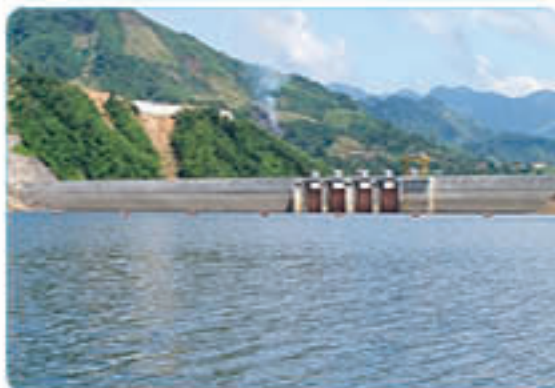
Hình 8.9. Đập dâng tại nhà máy thủy điện Đăkđrinh, Sơn Tây
