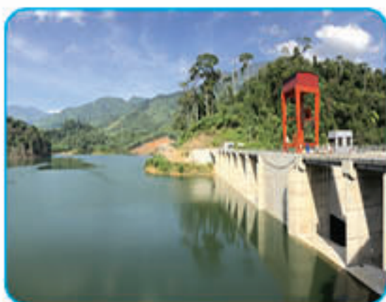
Hình 2.6. Thủy điện Sơn Trà
