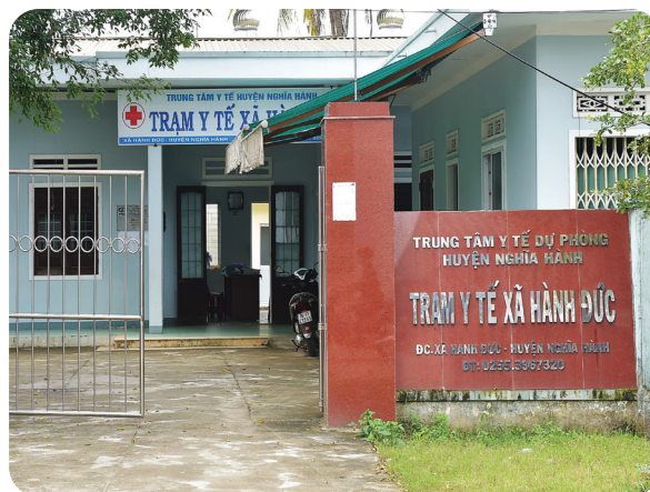
Hình 12. Trạm y tế xã Hành Đức, huyện Nghĩa Hành
